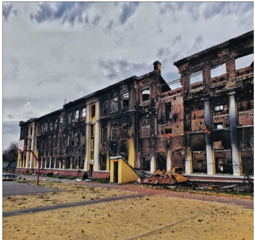
Le bâtiment de la mairie de la ville détruit
